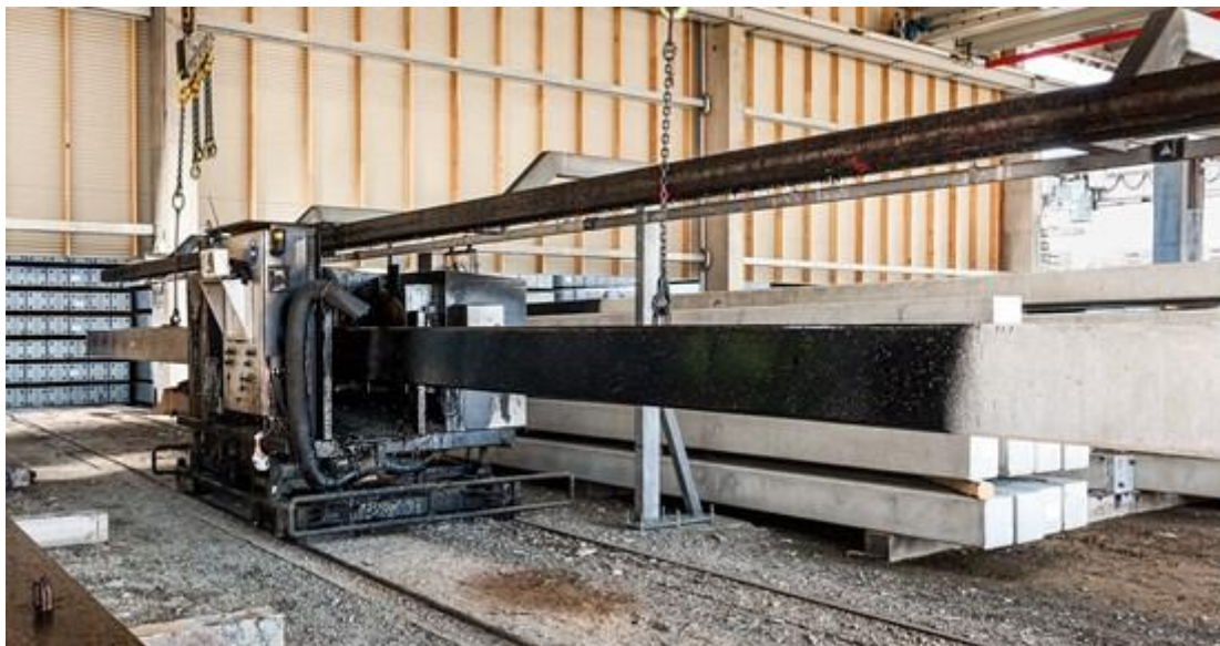
Figur 5-12 Asfaltering af pæl ved påføring af bitumen
