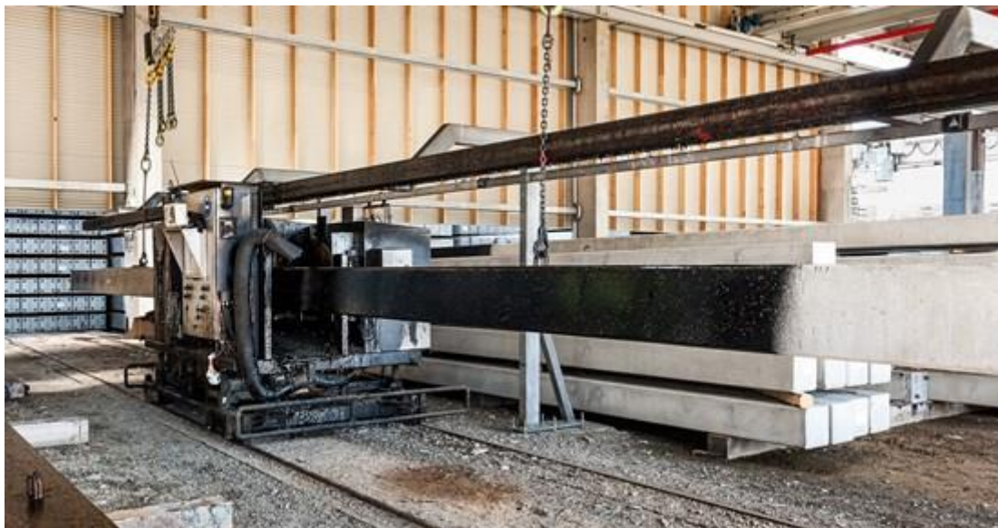
Figur 5-12 Asfaltering af pæl ved påføring af bitumen
