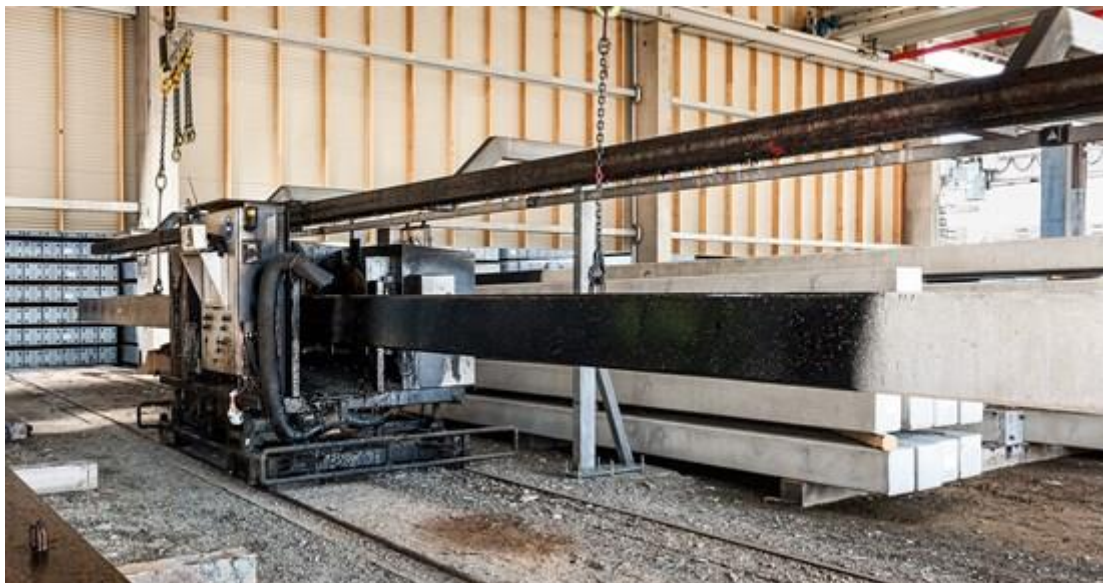
Figur 5-12 Asfaltering af pæl ved påføring af bitumen
